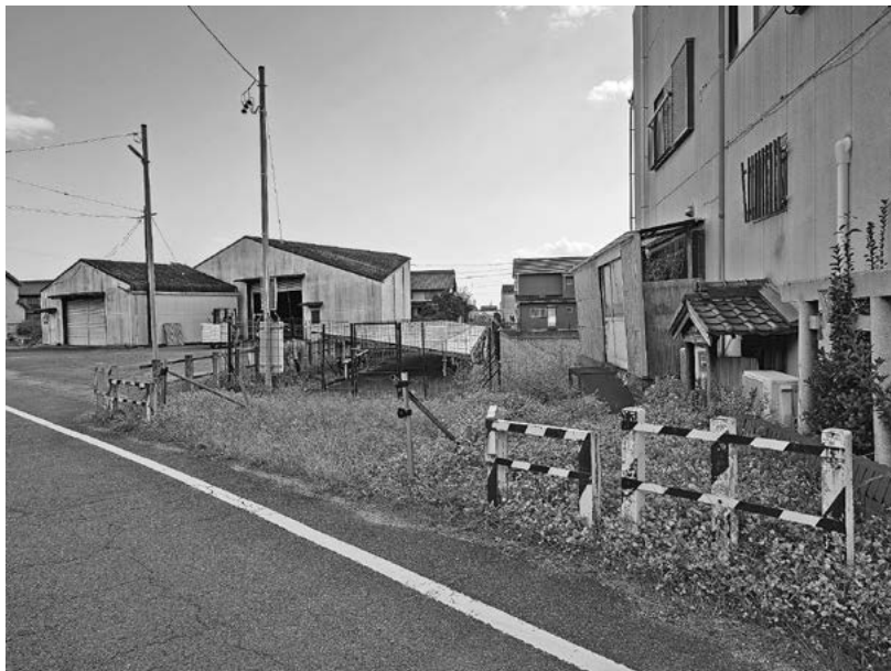
図4 太陽光発電設備が設置された旧三河線跡（三河一色駅・旧松木島駅間）
